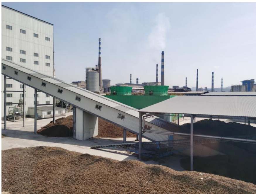
图 50 吉林通化生物质发电厂厂区
