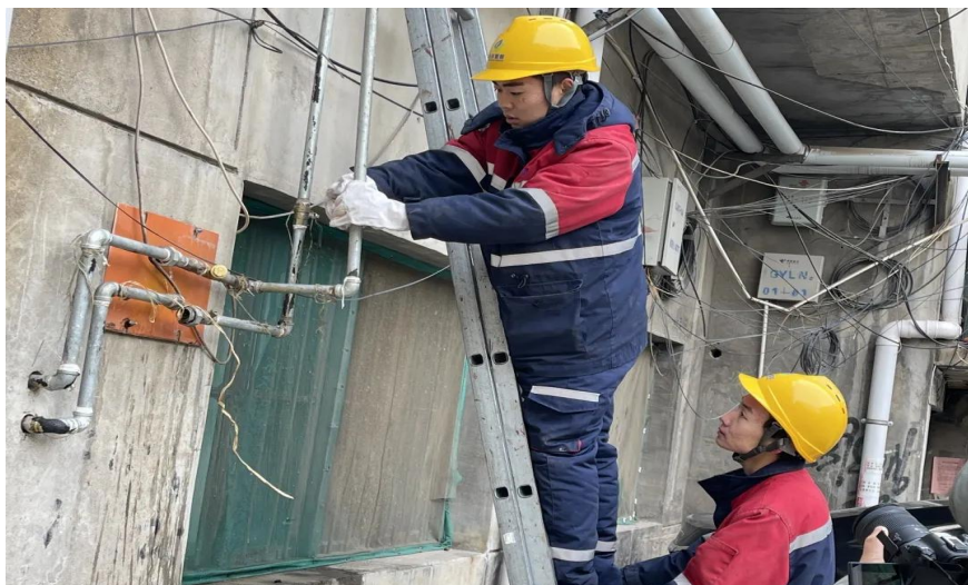
图 77 垣曲公司抢修供热管道
